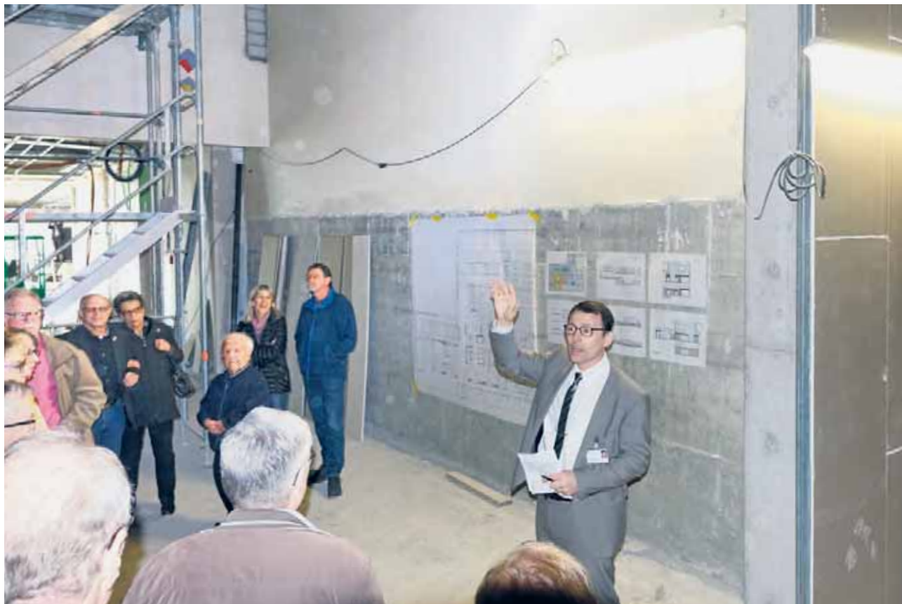
Spitaldirektor Norbert Vetterli informiert über die Bauarbeiten für das neue Restaurant.
