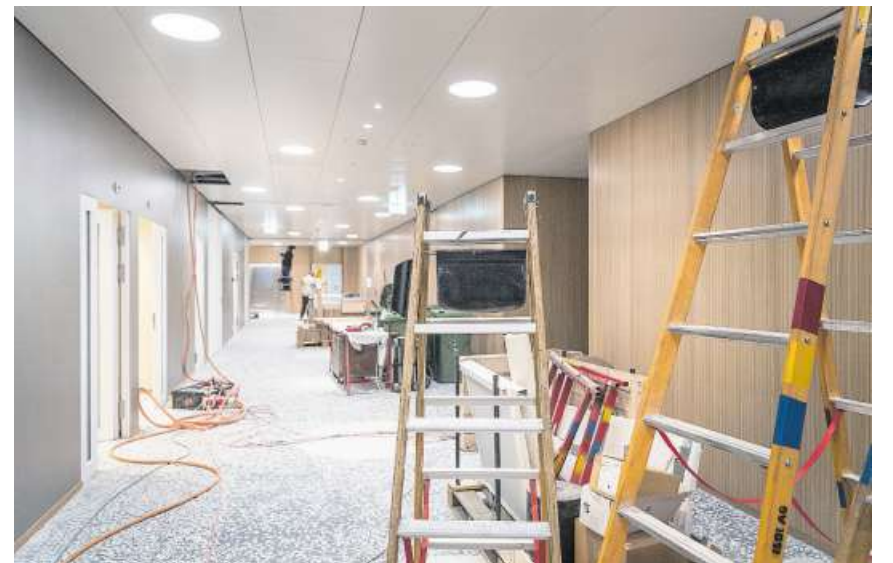
In den Gängen des Neubaus arbeiten Handwerker.
