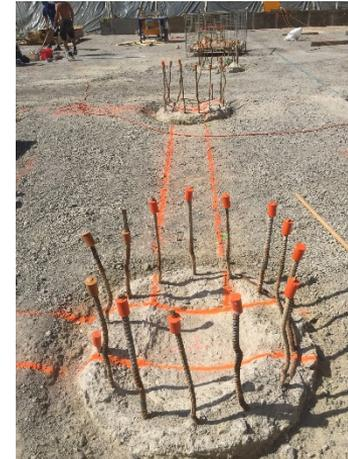
Bohrpfahl mit Anschlussbewehrung
