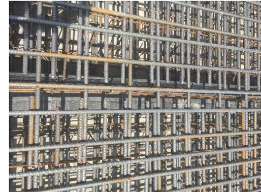
Erhöhter Bewehrungsgehalt Bodenplatte und mittigem Fugenband
