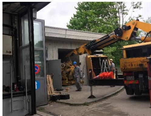
Rückbau altes Notstromaggregat
