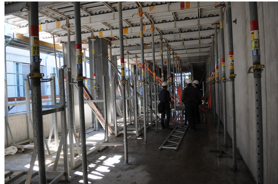
EG00 Innenansicht Bürobereich
