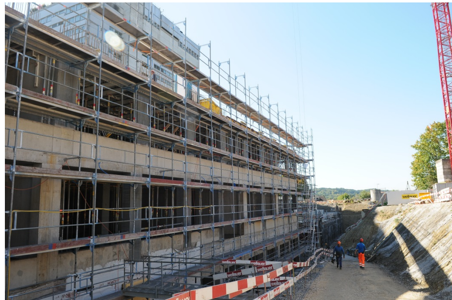
EG00 Aussenansicht Bürobereich
