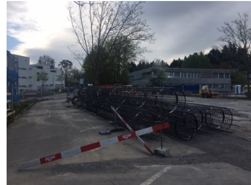
Vorgefertigte Bewehrungskörbe für Grossbohrpfähle
