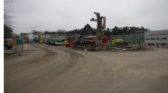
Erdwärmesondenbohrungen – Februar 2017
