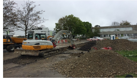
Leitungsgräben Erdwärmesonden
