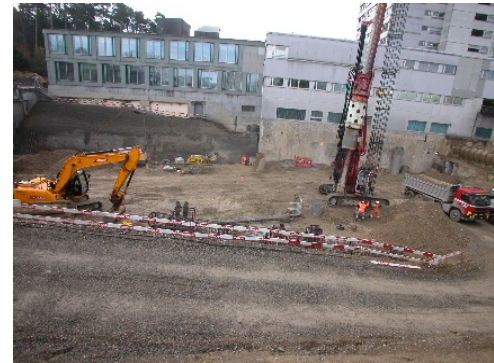
Bohrungsarbeiten für die Pfählung
