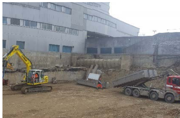
Baugrubenaushub neues Bettenhauses
