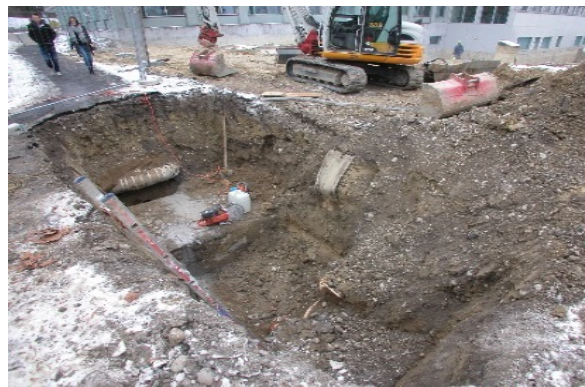
Grabenarbeiten KSF – Januar 2017
