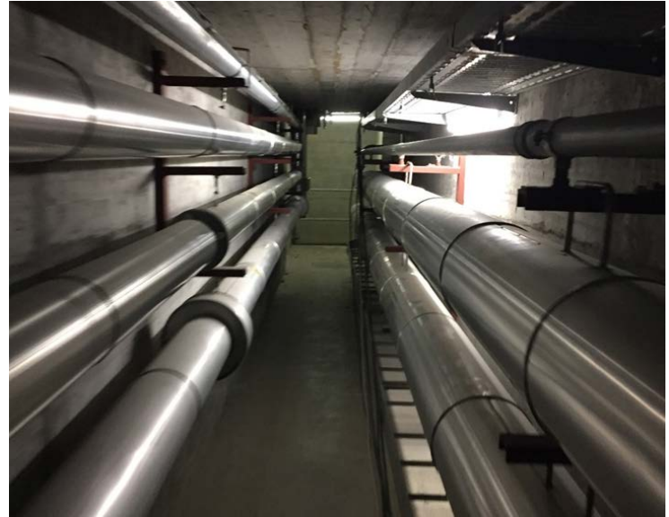
Abbruch Medienkanal – Februar 2017
