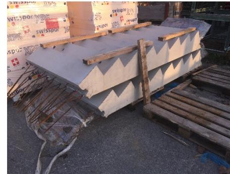
Fertigteiltreppenläufe mit Anschlussbewehrung warten auf ihren Einbau
