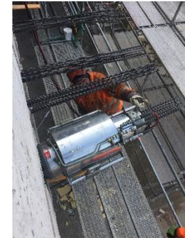
Spannvorgang mit Ausziehlingen zur Ermittlung der Vorspannkraft
