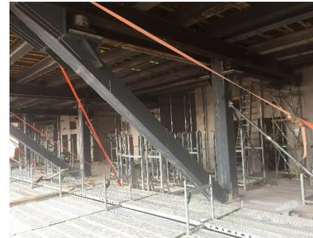
Fertig erstellte Betonieretappe Decke über 2. OG mit Verspannungen
