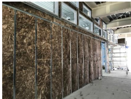
Brandschutzwand zu Konferenzsaal OG02
