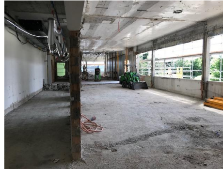
Abbruch Südfassade OG01
