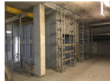
Liftschacht Zentrallager UG02
