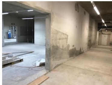
Rampe zwischen Neubau und Zentrallager UG02
