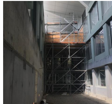
Vorbereitung Abbruch Passerelle
