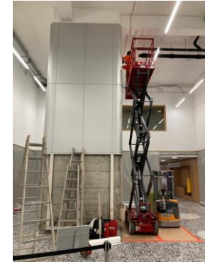
Start Abbruch mittels Hebebühnen
