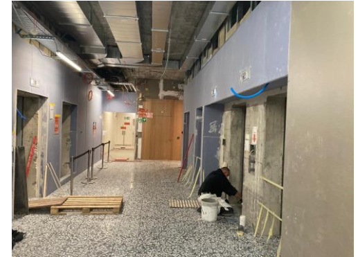
Liftvorplatz während Kunststeinarbeiten
