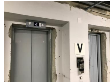
Einbau vom zweiten Personenlift
