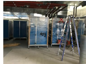
Einbringung der Lüftungsmonoblöcke
