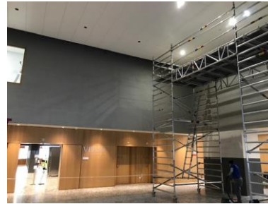
Eingangshalle nach Deckeneinbau
