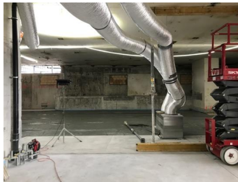
Vorbereitungen für Unterlagsboden in Technikzentrale OG02
