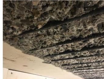
Betonoberfläche nach dem Jetten
