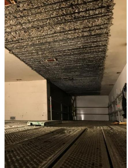
Freilegung der Armierung mittels Jett-Verfahren
