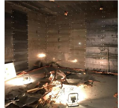
Magnetabschirmung aus Stahl und Kupfer
