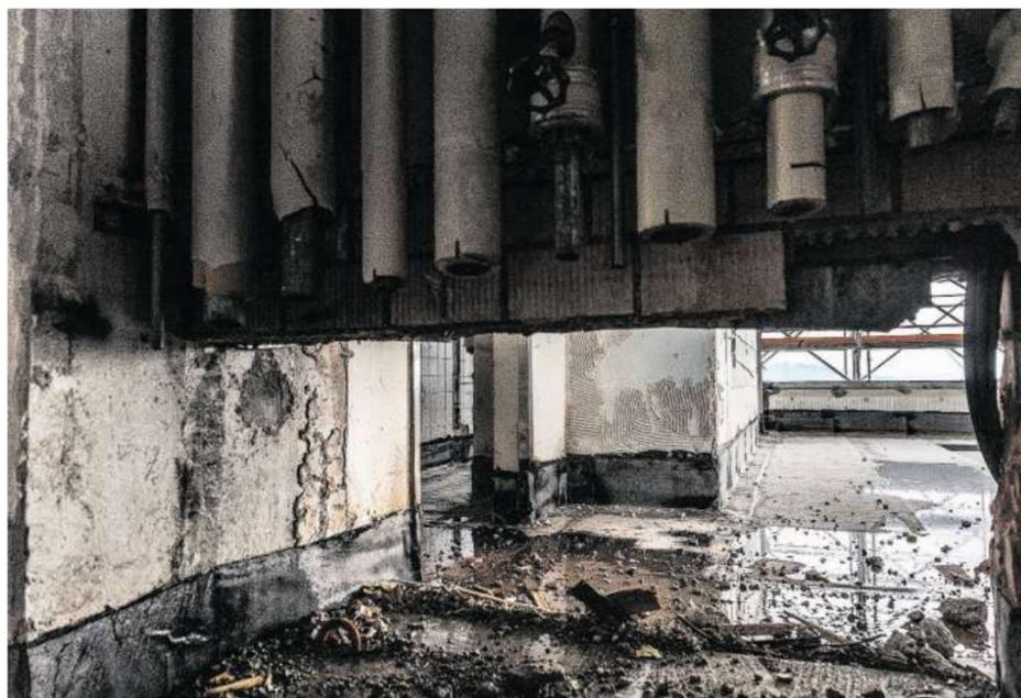
Die Versorgungsleitungen sind oberhalb des Sockels im Geschoss D abgeschnitten worden.
