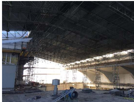
Fertiggestelltes Notdach über der Option 48
