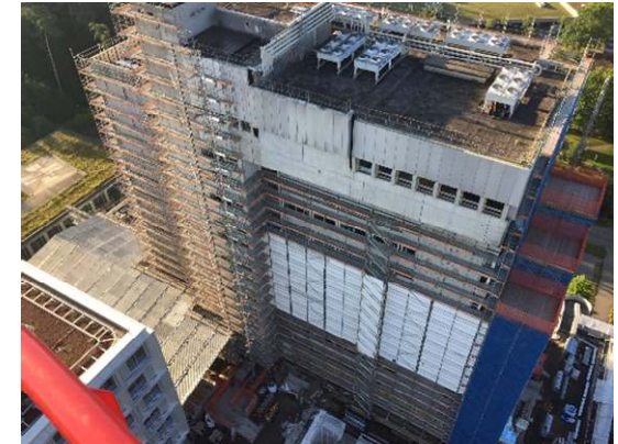
Schadstoffsanierung auf der Nordseite
