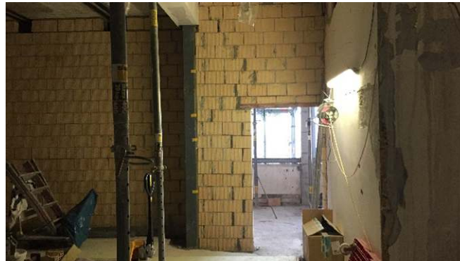
Maurerarbeiten und statische Massnahmen
