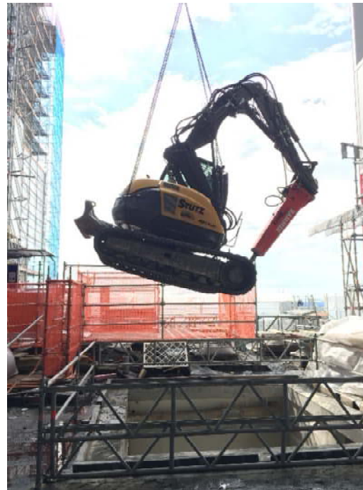
Einsetzen des Baggers am 17.08.2020
