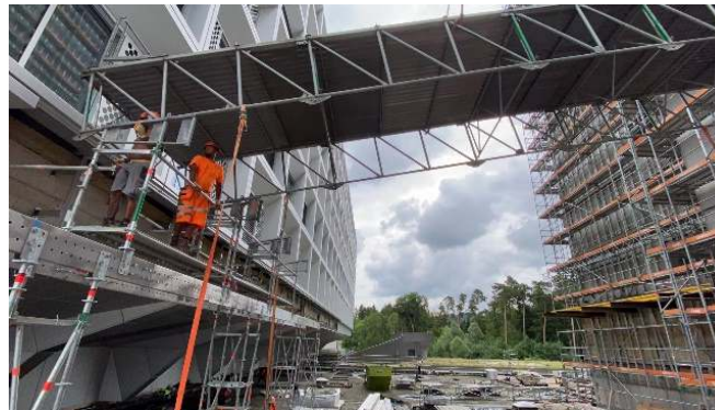
Montage des ersten Dachelements 03.07.2020
