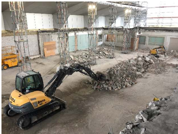
Abbruch Decke und Wände Geschoss OG01
