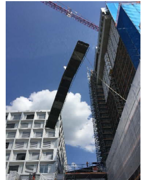
Montage Dachelement
