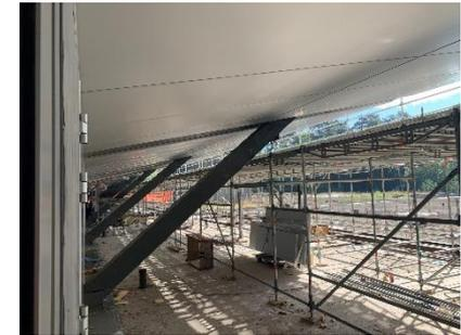
Montierte Bleche der Untersichtsverkleidung im 2. Obergeschoss
