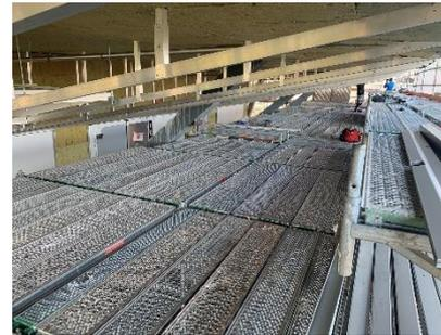
Flächengerüst und Unterkonstruktion für die Untersichtsverkleidung im 2. Obergeschoss
