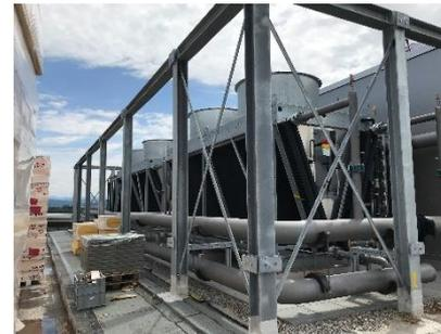
Montierte Rückkühler im 9. Obergeschoss vor Montage der Streckmetalle
