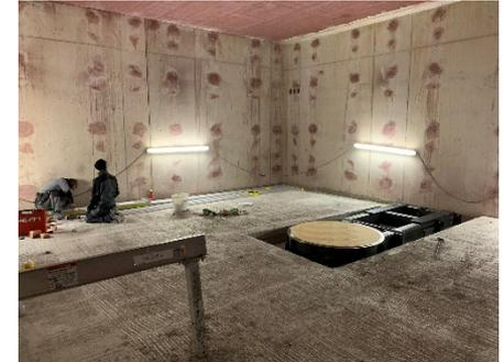
Montierte Unterkonstruktion des Linearteilchenbeschleunigers im Strahlenschutzbunker
