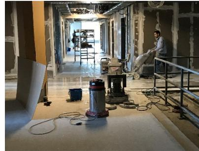
Vorgang des «Nassschleifens» der Kunststeinböden in den Korridoren
