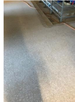
Zuvor nassgeschliffener und anschliessend durrierter® Kunststeinboden in den Korridoren
