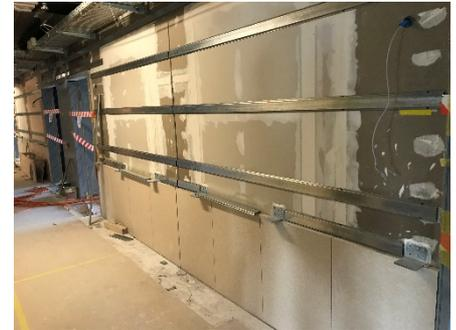
Untere Natursteinverkleidung und montierte Unterkonstruktionen an den Korridorwänden zur späteren Montage der Handläufe und der Wandverkleidungen
