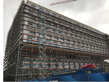
Nach der Fensterelementmontage wurde das Bettenhaus erneut eingerüstet, um die Aluminiumzargenelemente an der Fassade montieren zu können
