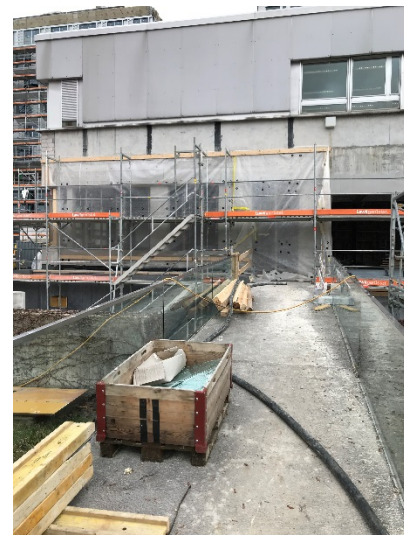
Auch die zweite Brücke am Restaurant wird künftig ihre Funktion erfüllen
