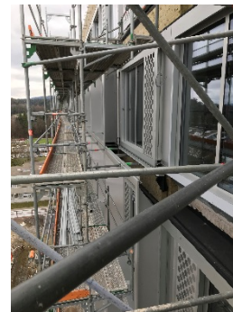
Komplexes Zusammenspiel zwischen Fassadenelementen und Gerüst
