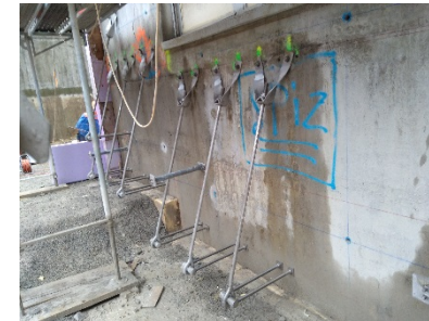
Fassadenankersystem FPA 5Z der Fa. Halfen an der Ortbetonaussenwand im 2. UG des Bestandsgebäudes montiert
