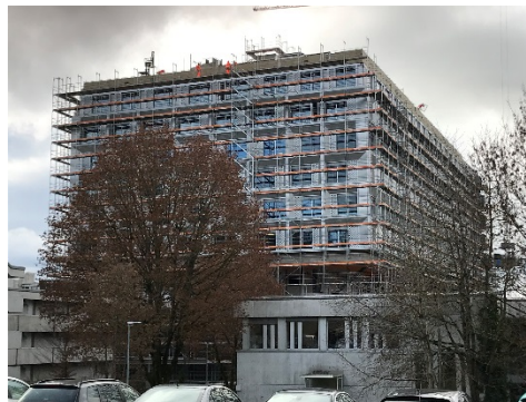
Ansicht Fassade Ost nach Abschluss der Fensterelementmontage neuer Bettenturm und Montage der Aluminiumzargenelemente der Fassade bis einschliesslich zum 7.OG
