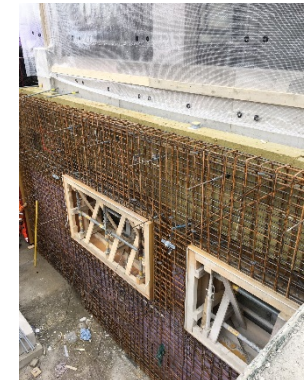
Fertig bewehrte Ortbetonfassadenelemente vor dem Schalungsschluss und der Betonage
