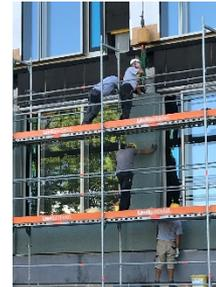
Die Montage der Betonfertigteilfassadenelemente verlangt den Einsatz qualifizierter Montagetrupps
