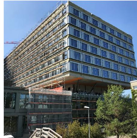
Ansicht Fassade Ost nach Abschluss der Fenstermontage neuer Bettenurm und Montage der Betonfertigteilfassade im Sockelbau
