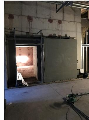
Zwischenzeitlich ausbetoniertes Tor zum Strahlenschutzbunker mit einer Wanddicke von 80 cm und einem Gewicht von 26 to
