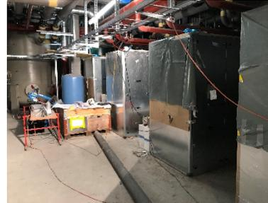
Aufgestellte Wärme- Kältepumpen mit Schutzfolie
