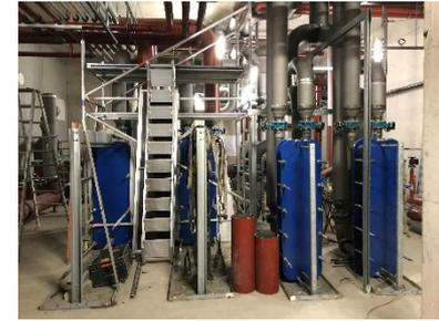
Plattenwärmetauscher bei der Montage im 2. Untergeschoss
