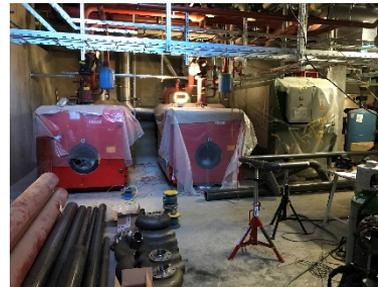
Links im roten Gehäuse die redundanten Gaskessel, rechts daneben das Blockheizkraftwerk, alles noch in Schutzfolien
