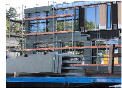
Abgetreppter Verlauf bei der Betonfertigteilfassadenmontage analog eines «Stecksystems». Im Vordergrund angelieferte Betonfertigteilteilelemente die zur Montage bereit stehen
