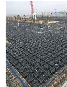
Direkter Vergleich zur Ausführung der Hohlkörpermodule zwischen der Bewehrung. Die weißen TABS Schläuche sind zudem gut sichtbar.
