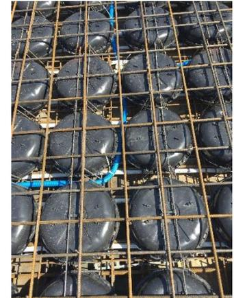
Cobiax® Hohlkörpermodule fertig eingebaut direkt vor der Betonage.
