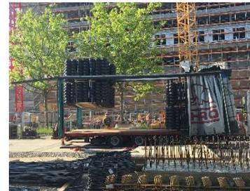
Anlieferung von vorkonfektionierten Cobiax® Hohlkörpermodulen
