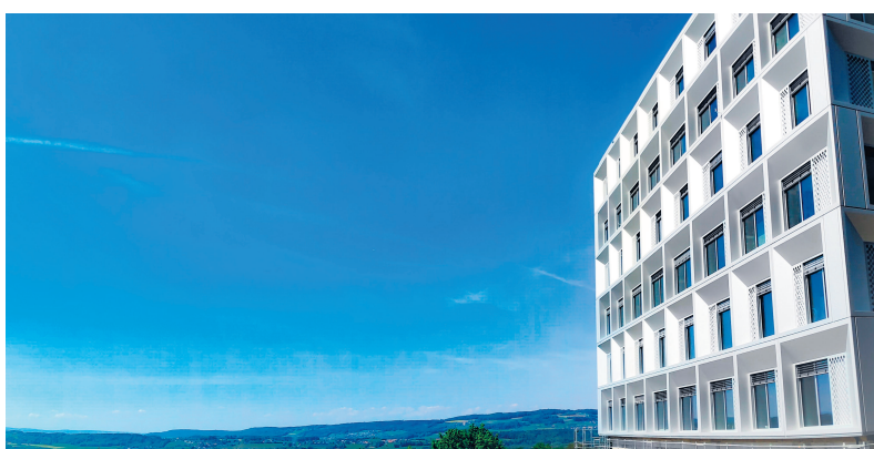
Der Neubau des Kantonsspitals in Frauenfeld.
