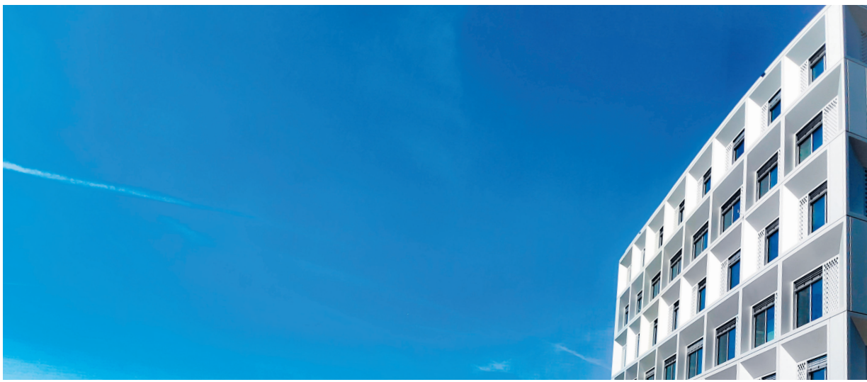
Der Neubau des Kantonsspitals in Frauenfeld.
