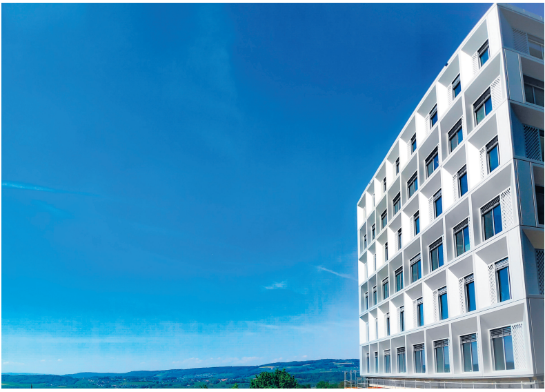
Der Neubau des Kantonsspitals in Frauenfeld.
