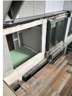
Anschluss Neubau zur entfernten Passerelle
