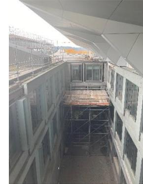
Abbruch mittels Flächengerüst
