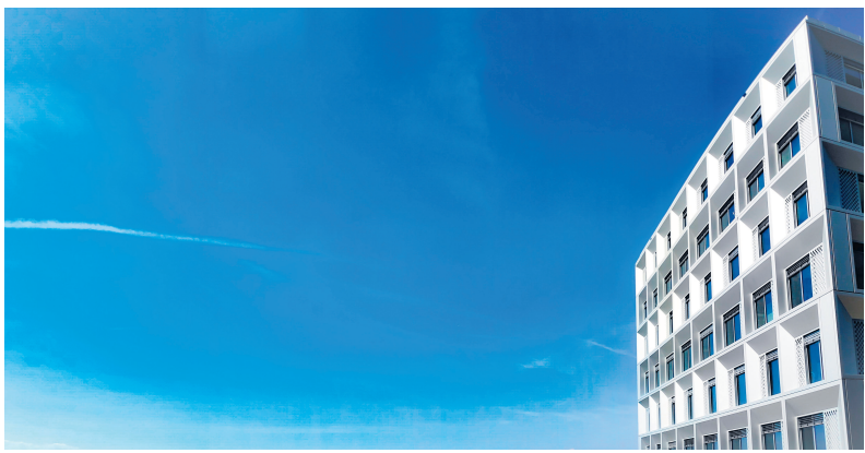
Der Neubau des Kantonsspitals: Bezug 1. Quartal 2020.
