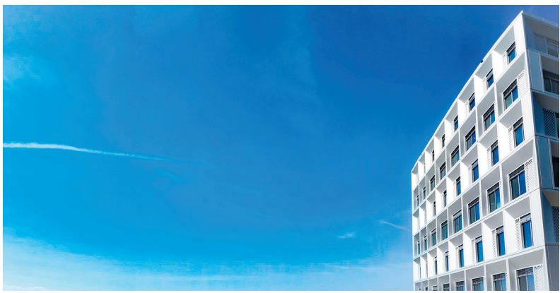
Der Neubau des Kantonsspitals: Bezug 1. Quartal 2020.
